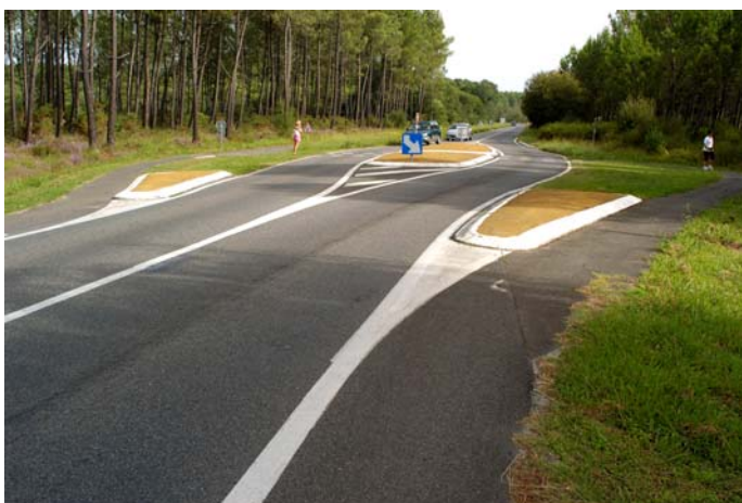
Cykelöverfarten från föregående bild. En bred mittrefug tydliggör överfarten, dämpar farten och låter cyklisten ta passagen i två etapper.
